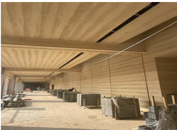
图3 洛阳某遗址博物馆内墙抹涂型夯土效果
